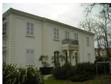
La façade principale de la résidence d'Anglet
